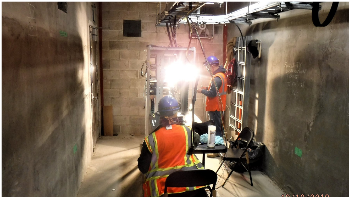
Instalação real de fibra óptica em infraestrutura crítica.
